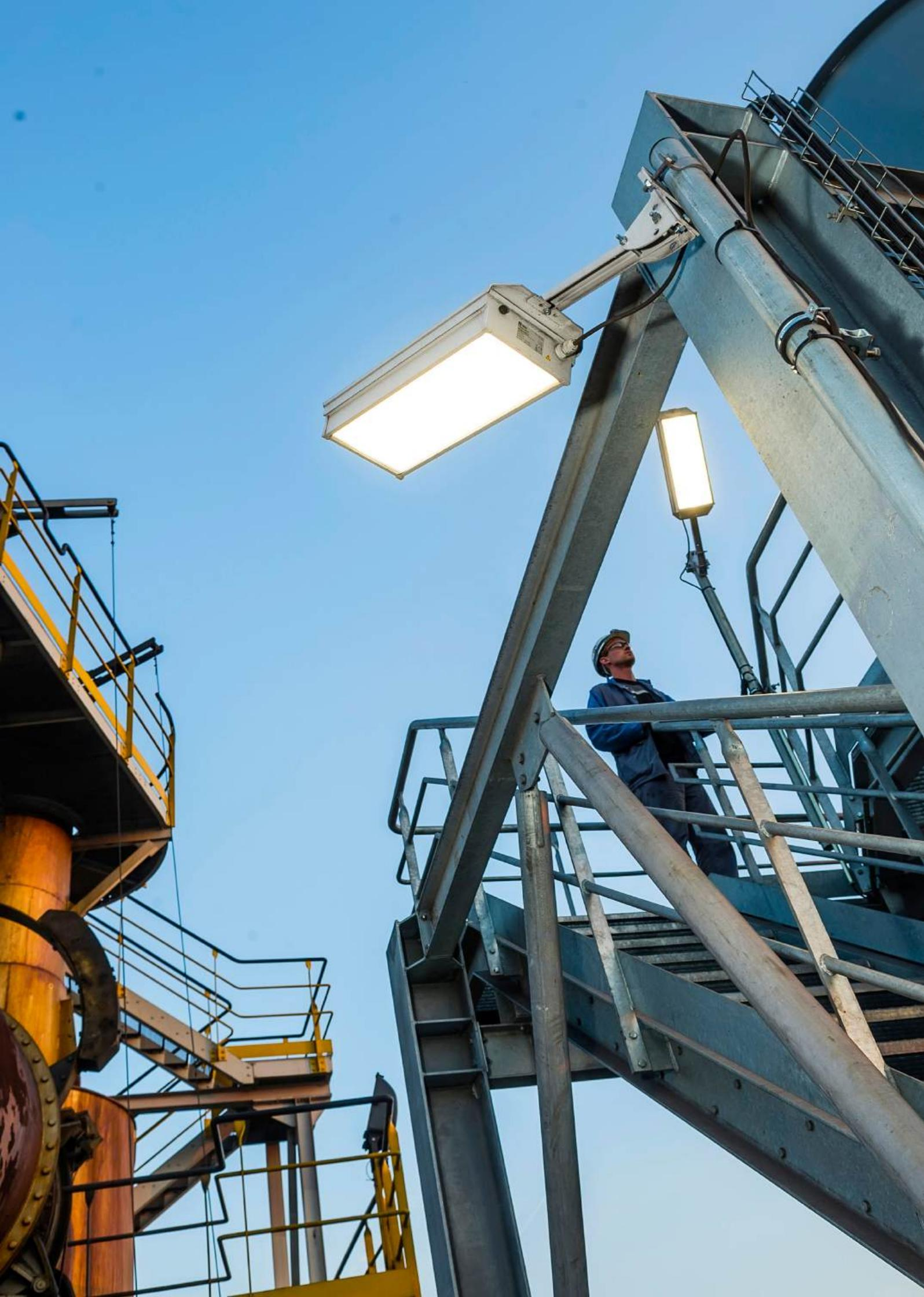
DANI ist eine kompakte, universell einsetzbare und umrüstbare LED-Leuchte mit Aluminiumrahmen. Das Technik-Paket dieser Leuchte kann ausgetauscht werden, so dass nicht die gesamte Leuchte am Ende ihrer Lebensdauer ersetzt werden muss.
