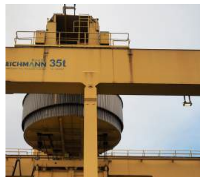
Éclairage de la grue
